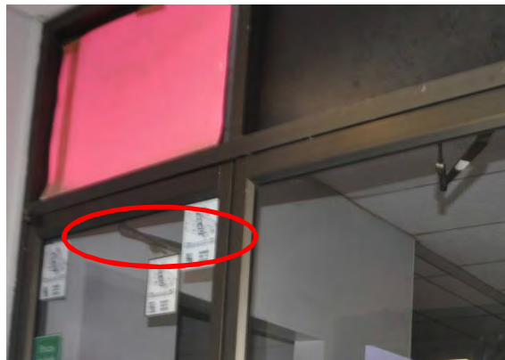
Figure 3-13 Inoperable Door Closer (Vestibule)
